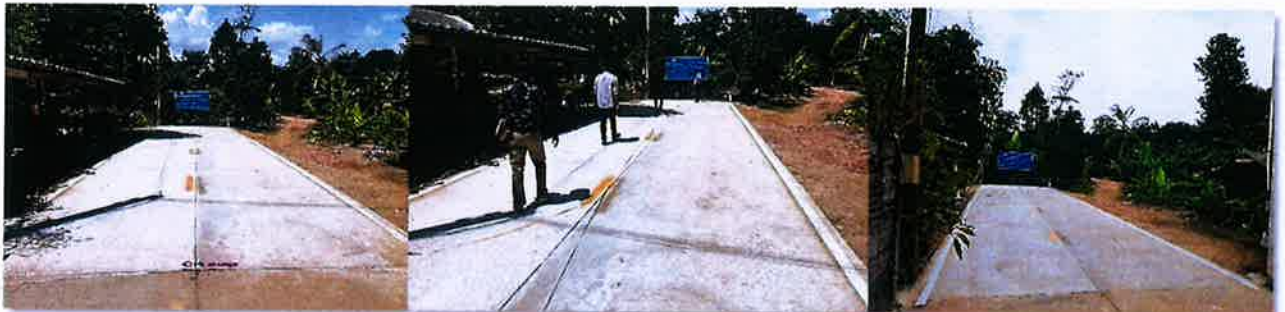
ดำเนินงานแล้วเสร็จ
